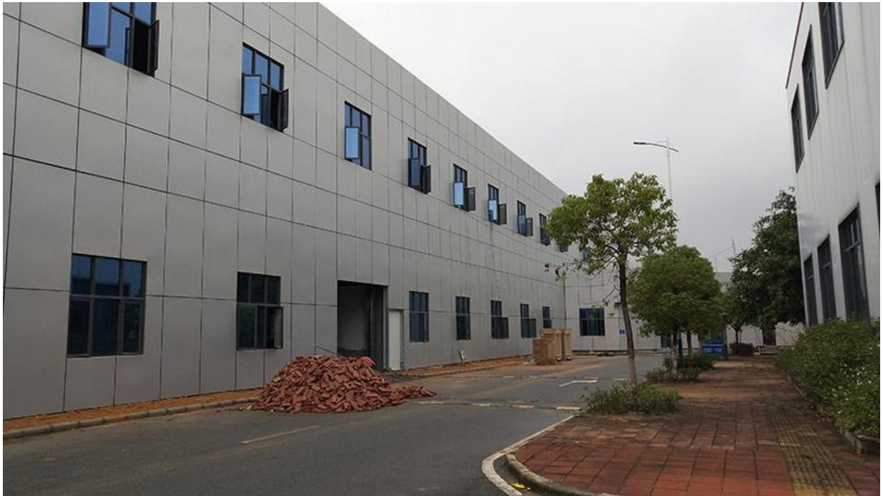
中汽修协连锁工委项目基地主体结构
